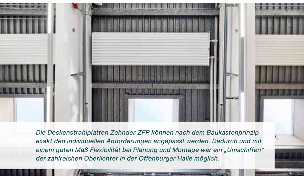
Die Deckenstrahlplatten Zehnder ZFP können nach dem Baukastenprinzip exakt den individuellen Anforderungen angepasst werden. Dadurch und mit einem guten Maß Flexibilität bei Planung und Montage war ein „Umschiffen“ der zahlreichen Oberlichter in der Offenburger Halle möglich.
