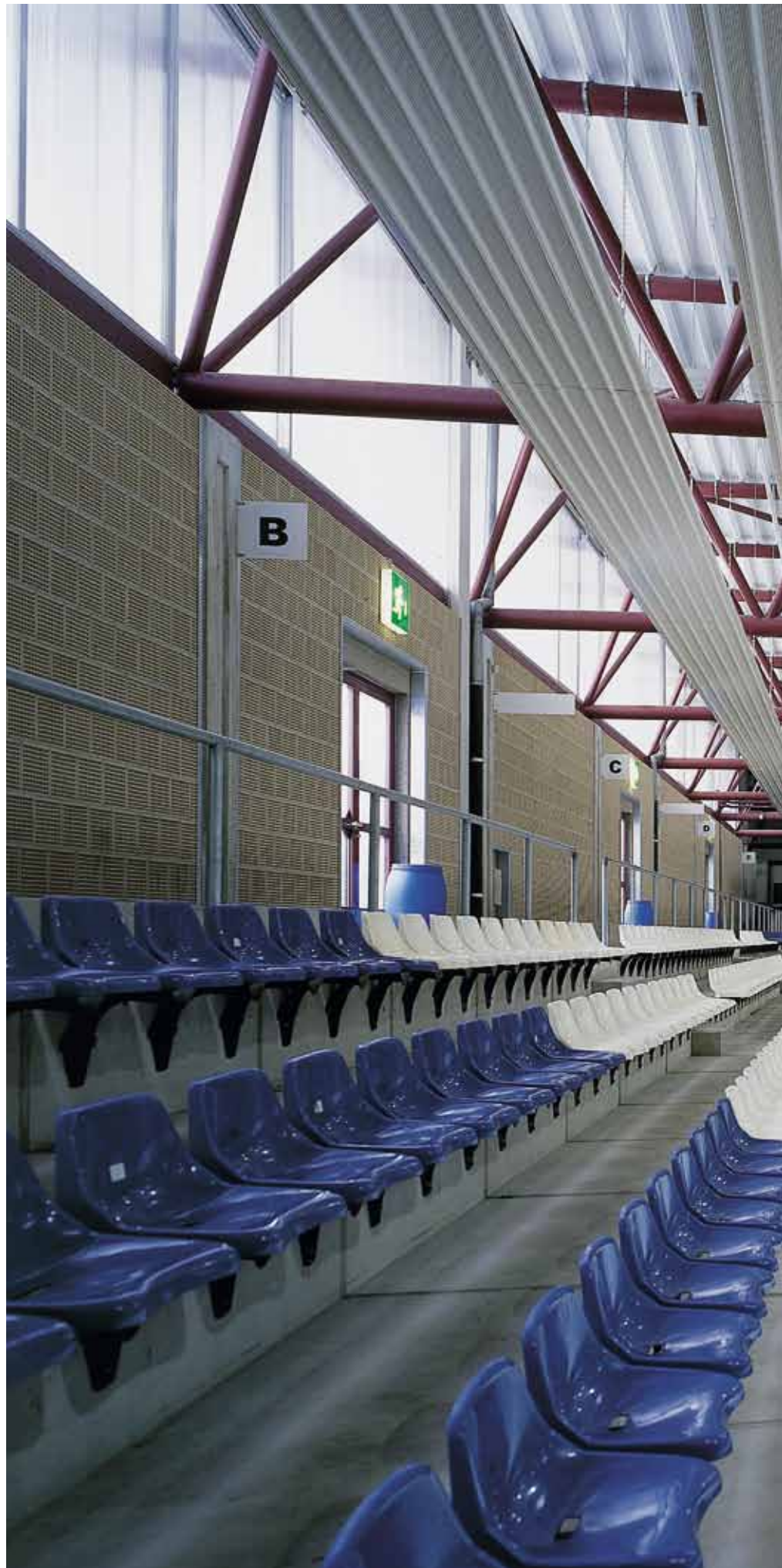
Eissporthalle Küsnacht (CH)
