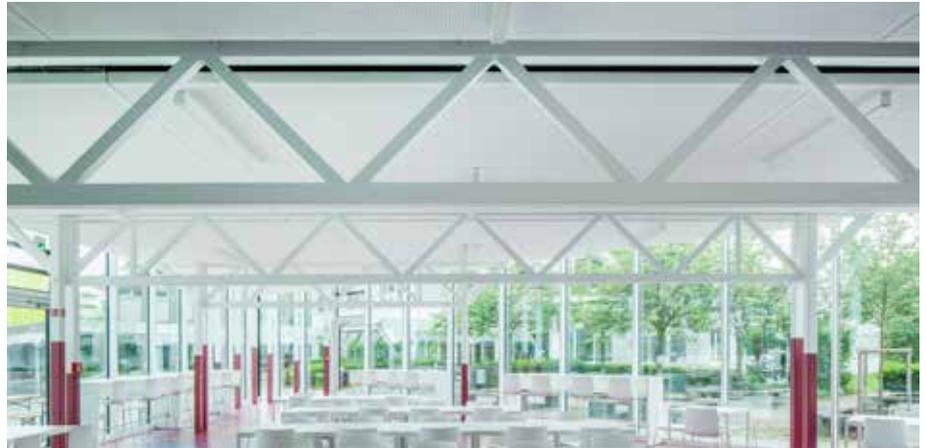
Zehnder Heiz- und Kühldecken-Systeme funktionieren nach dem Strahlungsprinzip: Von warmem Wasser durchströmt, geben sie dessen Energie überwiegend in Form von Infrarotstrahlung ab, die sich erst beim Auftreffen auf den menschlichen Körper oder Gegenstände in angenehme Wärme umwandelt.
