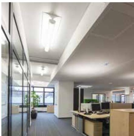
Die Ausführung der Zehnder Kühldecke als Gipskartonsegel ermöglichte eine flexible und damit optimale Anpassung des Deckenspiegels an die teilweise sehr unregelmäßig vorhandene Anordnung von Stützen, Unterzügen und Deckenfeldern.
