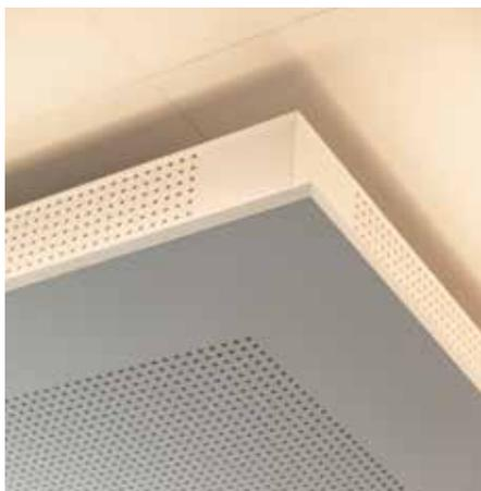
Die Geräuschdämmung übernimmt die Kühldecke: Schallwellen gelangen durch die Perforation der Gipskartonplatten direkt in ein Schallabsorptionsvlies, von dem sie absorbiert werden.
