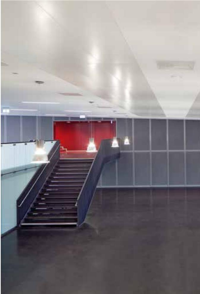
③ Im Foyer wurde das Heiz- und Kühldecken-System in das gestalterische Konzept inklusive abgehängter Deckenleuchten integriert.
