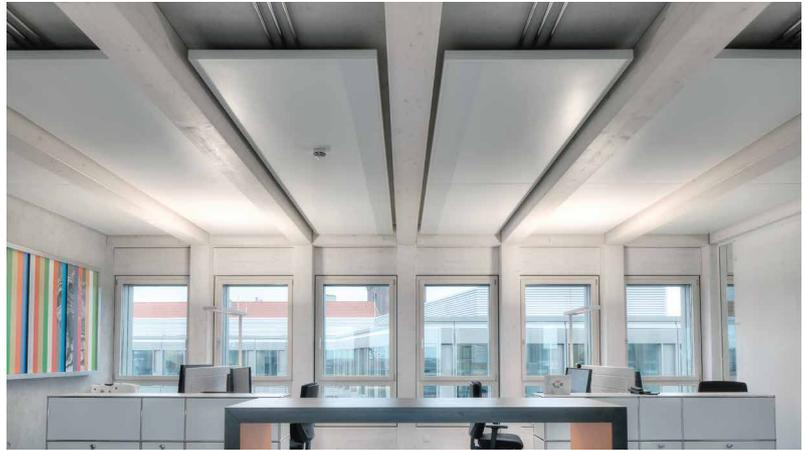
Im Gegensatz zur Luftklimatisierung findet der Wärmetransport innerhalb des Deckensystems via Wasser statt, was dank dessen hoher Wärmekapazität einen geringeren und ressourcenschonenderen Rohrdurchmesser erlaubt.
