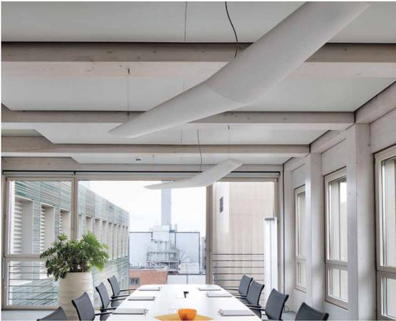
Von warmem Wasser durchströmt, geben die Zehnder Deckensegel ihre Energie überwiegend in Form von Infrarotstrahlung ab und sorgen für eine behagliche Wärme.
