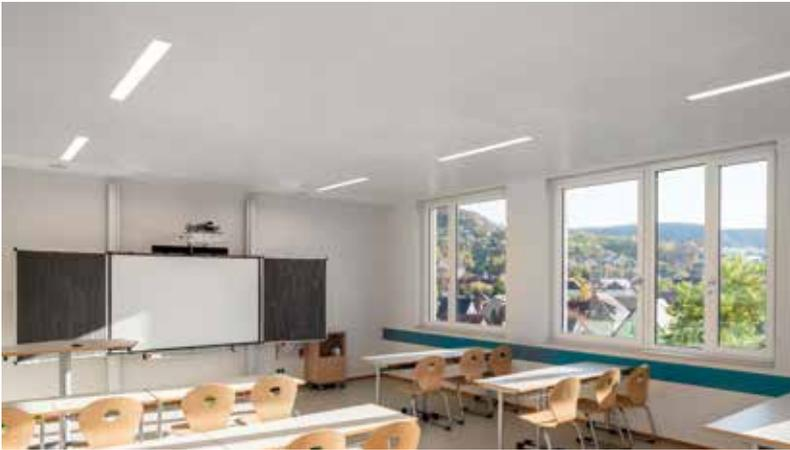
Insgesamt wurden in Jena gut 5.000 Module der Zehnder Einhängedecke in lediglich zwei verschiedene Modulgrößen, mit einer Gesamtfläche von 3.940 m<sup>2</sup> installiert.
