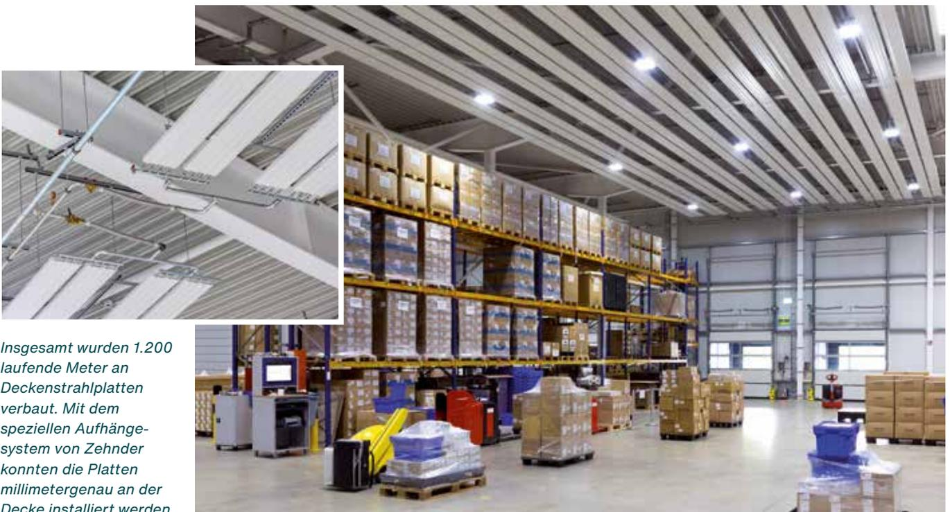
*Insgesamt wurden 1.200 laufende Meter an Deckenstrahlplatten verbaut. Mit dem speziellen Aufhängesystem von Zehnder konnten die Platten millimetergenau an der Decke installiert werden.*
