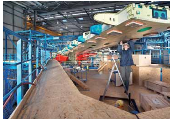
In der Versuchshalle waren wegen der äußerst sensiblen Messprozesse am Airbus 380 ungewöhnlich hohe Temperaturen von 20°C gefordert. Deshalb wurden zur Beheizung ausschließlich Deckenstrahlplatten eingesetzt, deren Energiespareffekte bei diesen Temperaturanforderungen voll zum Tragen kommen.
