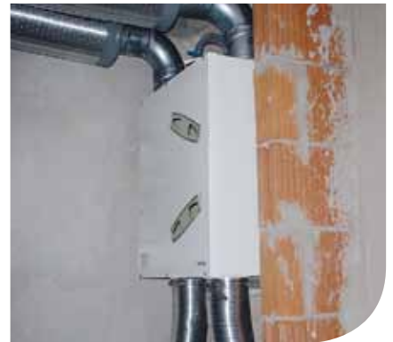
Zehnder ComfoAir 140 Rohbausituation
