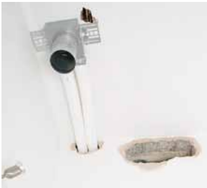
Luftdurchlass innerhalb der später abgehängten Decke im Bad
