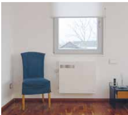
Zehnder ComfoAir 100 mit Zuluftanschluss vorne und Abluft seitlich
