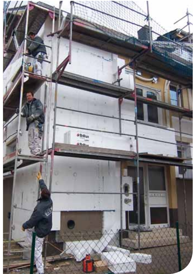
Dämmung während der Bauphase
