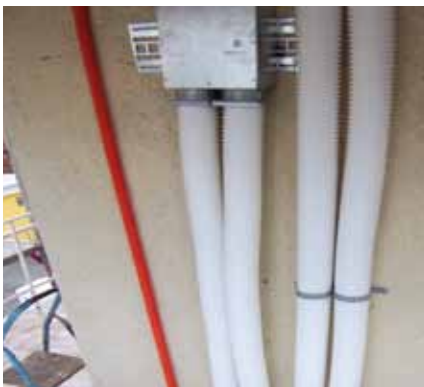
Luftdurchlassgehäuse TVA für Abluft mit Zehnder ComfoTube 75 entlang der Fassade
