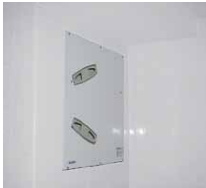
Zehnder ComfoAir 140 im Bad. Integriert in Trockenbauwand
