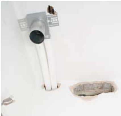
Luftdurchlass innerhalb der später abgehängten Decke im Bad
