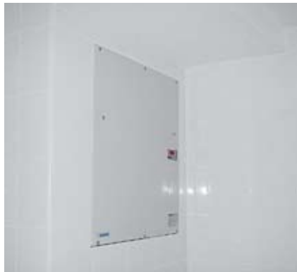
Zehnder ComfoAir 140 im Bad. Integriert in Trockenbauwand
