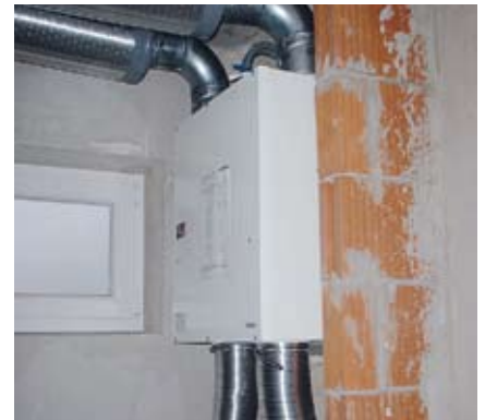
Zehnder ComfoAir 140 Rohbausituation
