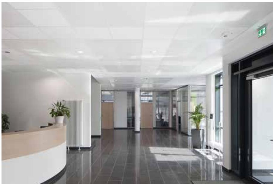
Ebenfalls in den Flurbereichen sorgen Zehnder Heiz und Kühldecken für eine angenehme Wärmeverteilung. Auch optisch wirken die geschlossenen Deckenmodule und korrespondieren harmonisch mit den Lichtauslässen.
