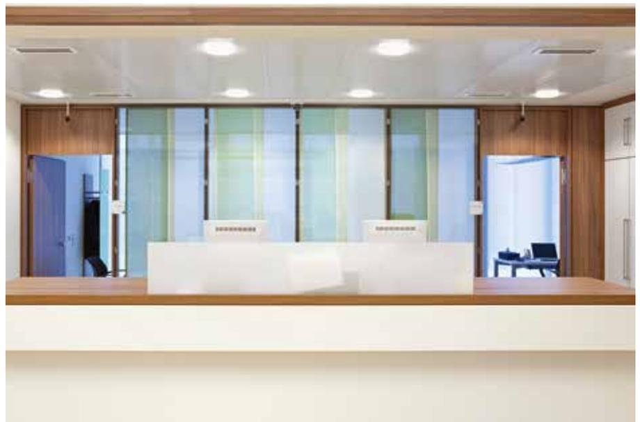
Die „Carboline“ Deckenelemente eignen sich sowohl im Kühl- als auch zum Heizbetrieb. Durch die hohe Wärmeleitfähigkeit des Werkstoffs Naturgraphit und die geringe Masse der Elemente werden kurze Ansprechzeiten erreicht.
