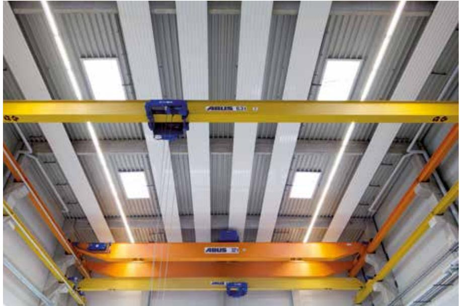
Flexible Montage: In einer älteren Halle mit Sheddach war es kein Problem, die Zehnder Deckenstrahlplatten an die Raumgeometrie angepasst parallel zur Decke aufzuhängen. Die 20 Prozent Schräglage beeinträchtigt Effizienz und Behaglichkeit der Wärmeverteilung über die Strahlplatten dabei nicht.
