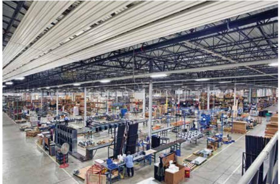
Effizientes Detail: Ein Großteil der Energie, mit dem das Deckenstrahlssystem betrieben wird, kommt aus der Abwärme der werkseigenen Lackierbox. So heizen und kühlen die Strahlplatten zu 98 % der Zeit mit kostenloser Wärme.
