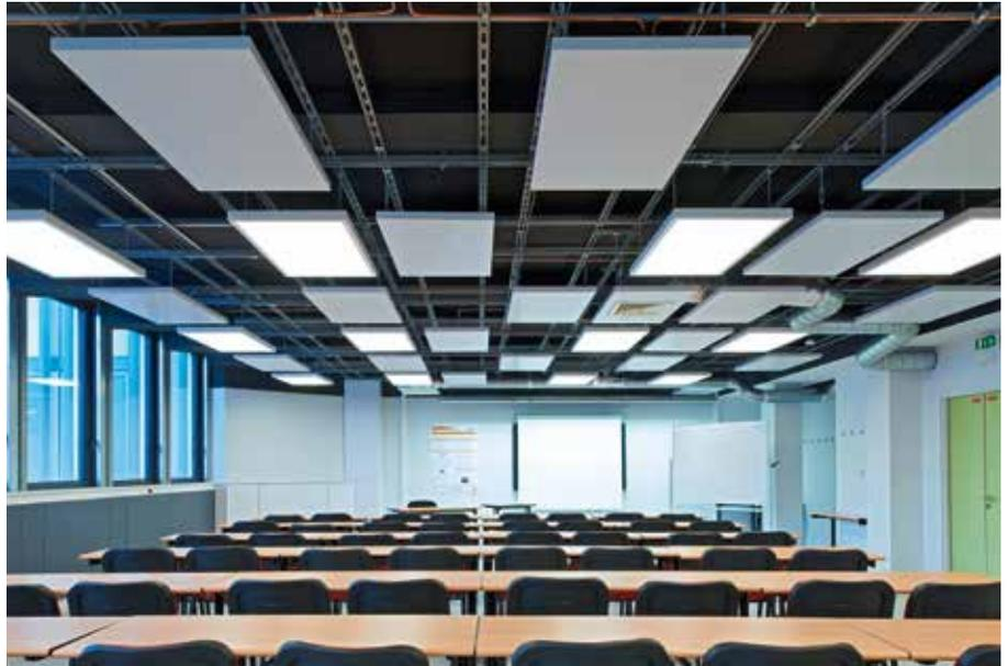
Form und Oberfläche der Heiz- und Kühlsegel wurden so gewählt, dass sie sich perfekt in das architektonische Gesamtkonzept einpassen. Teilweise wurden auch Beleuchtungselemente in die Paneele integriert.
