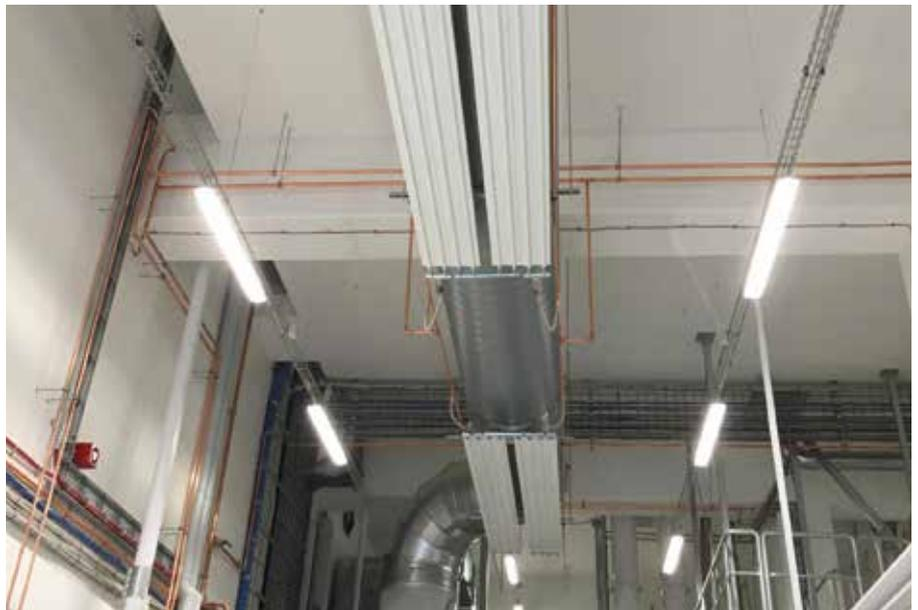
Das Heizsystem von Zehnder stellt eine effiziente Form der Zuwärme dar: Die Industrierwärme ist aufgrund der extrem kalten Wintermonate in Plauen nicht ausreichend für eine annehmbare Temperatursituation in der Mühle. Durch die korrosionsgeschützte Ausführung der Zehnder Deckenstrahlplatten kann sich zudem kein Ungeziefer einnisten. So wird stets eine optimale Hygiene garantiert.
