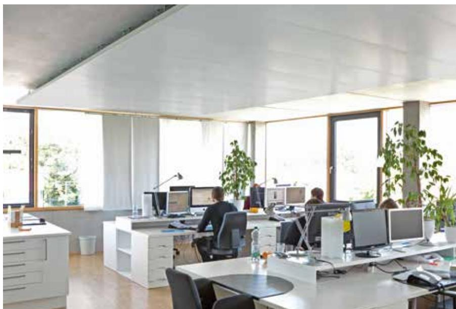
Sämtliche Büroräume samt Cafeteria werden mit Zehnder Heiz- und Kühldeckensegel klimatisiert. Die Leichtbauplatten mit Naturgraphit sorgen für besonders schnelle, gleichmäßige und effiziente Temperaturverteilung.
