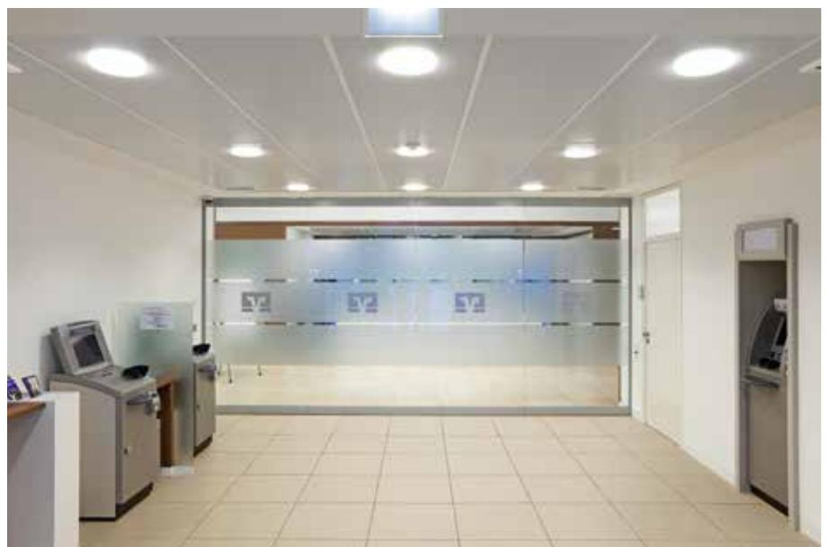
Behagliches Raumklima im Foyer: Die Zehnder Carboline Deckenelemente kühlen nicht nur zugluftfrei und lautlos, auch die Beleuchtung und Lüftungsauslässe ließen sich harmonisch in die Kühldecke integrieren.
