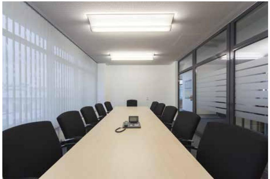
Zehnder Gipskartonsegel kühlen – im Gegensatz zur klassischen Umluftkühlung – durch passive Kühlung über Kühlelemente, die ohne großen Aufwand und optische Einschränkungen sehr praktikabel in jeder Decke integriert werden können.
