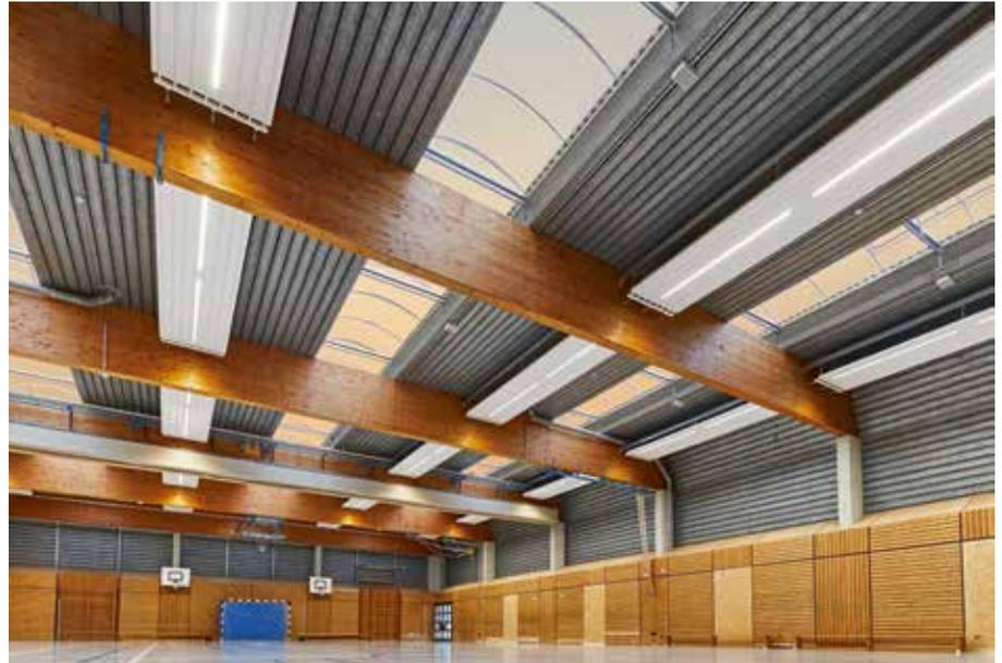
In der Georg-Schindler-Sporthalle wurden insgesamt 24 Deckenstrahlplatten Zehnder ZBN mit integrierten LED-Einbauleuchten installiert. Die energiesparende 2-in-1-Lösung wurde per Kettenabhängung an Weitspannträgern befestigt. Die Verbindung der einzelnen Deckenstrahlplatten-Elemente erfolgte mittels Panzerschläuchen, welche entlang der Deckenkonstruktion mehrfach durch vorgefertigte Leimbinderbohrungen geführt wurden.
